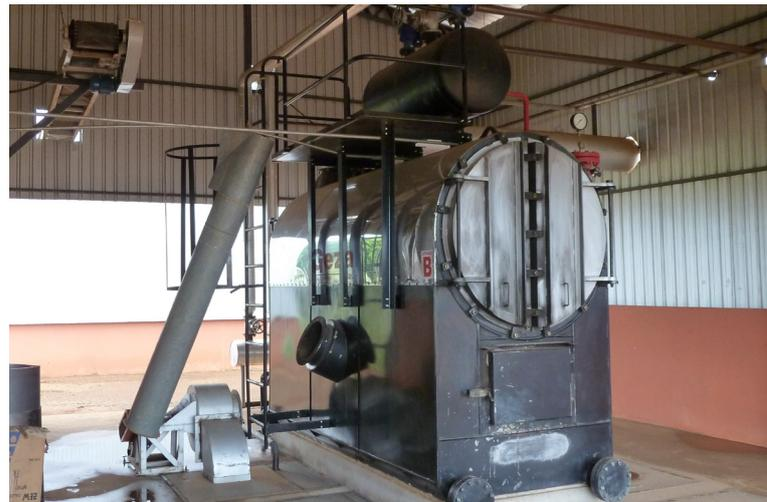
A necessidade de utilização de combustíveis sólidos para caldeiras pequenas, como nas usinas de beneficiamento de algodão, fez surgir o tipo misto. Basicamente são caldeiras flamotubulares com uma antecâmara de combustão com paredes revestidas de tubos de água. Na antecâmara se dá a combustão de sólidos usando grelhas de diversos tipos.
